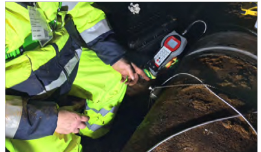
KATflow 200 installé sur une canalisation d'égout de gros diamètre.
