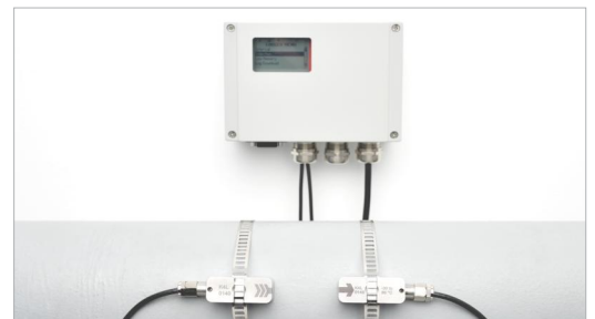
Zwei KATflow 100-Durchflussmesser wurden als Teil eines kombinierten Mess-, Überwachungs- und Warnsystems permanent installiert.
