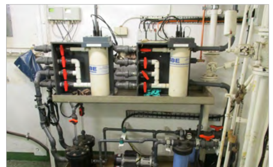
KATflow 100-Installation als Bestandteil eines Thermosalinographensystems auf dem FS METEOR.
