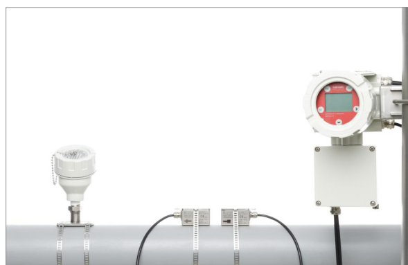
Датчик типа PT100 ATEX установленный на трубе вместе с датчиками K1Ex и прибором KATflow 170
